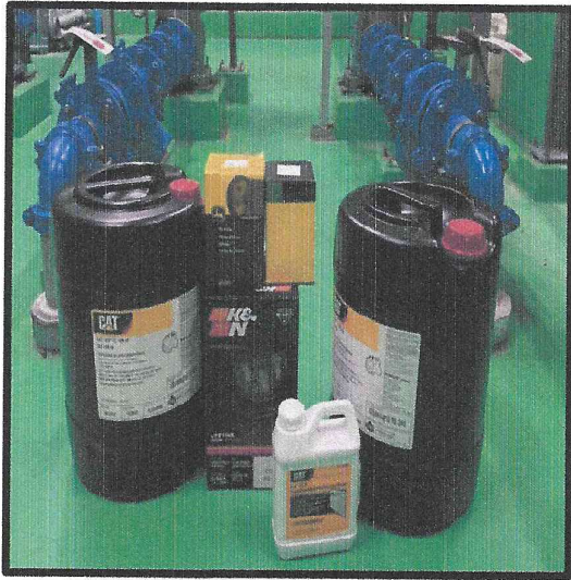
รูปแสดงอุปกรณ์สำหรับเปลี่ยนเครื่องยนต์ Fire Pump
