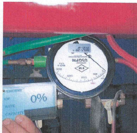
ทดสอบที่ 0 % ได้ค่าแรงดัน 200 PSI
